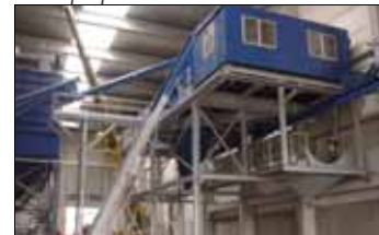
Installatie ter plaatse
